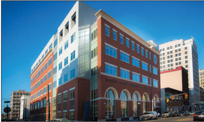
El nuevo Edificio de la Biblioteca, ubicado en el 71 Sip Avenue, en el campus de Jersey City. Con aproximadamente 112,000 pies cuadrados, está equipado con lo último en tecnología.
